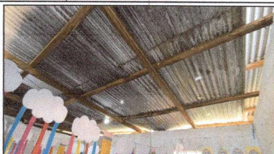
FOTO 8: Sustitución de lámina, por lámina troquelada aluzinc calibre 26 Y Sustitución de estructura de soporte de madera, por metal
