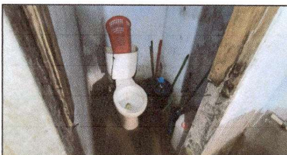
FOTO 3: Sustitución de piso cerámico y Sustitución inodoro
