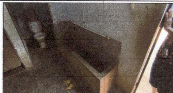
FOTO 2: Sustitución de piso cerámico
