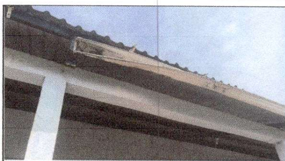
FOTO 10: Sustitución de canal de metal, Reparación de bajada de agua pluvial, tubo PVC 3" Y Sustitución de soporte o pescante de metal para canal
