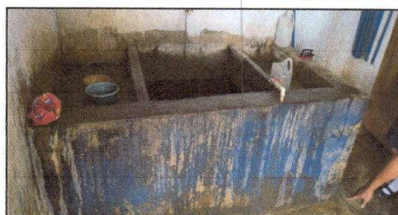
FOTO 4: Sustitución de Azulejo
