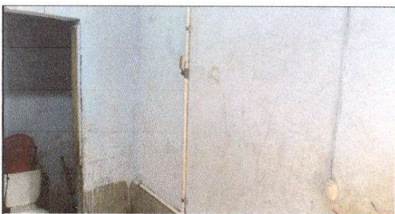
FOTO 5: Sustitución de tubería línea principal
