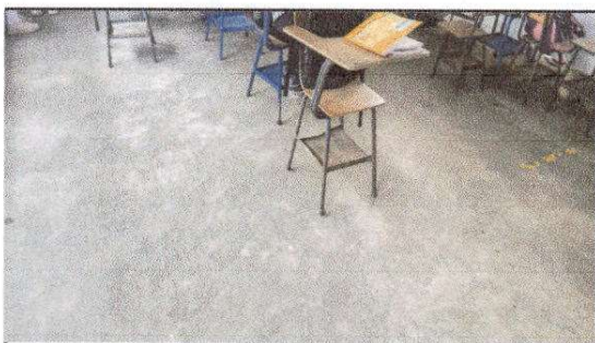
FOTO 9: Sustitución de piso cerámico
