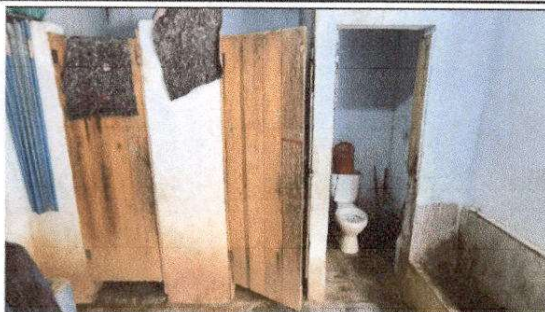
FOTO 7: Fabricación e instalación de puertas de metal en baños
