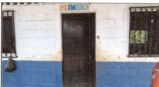
FOTO 12: Fabricación e instalación de puertas de metal en módulos.
